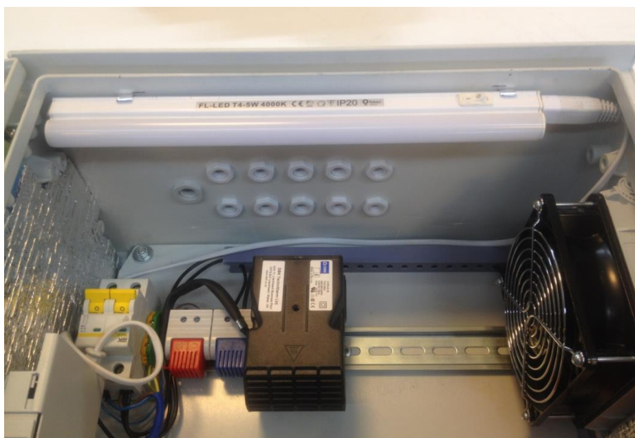
Рис.1-2 Установка светильника в уличную станцию в пластиковом корпусе.
