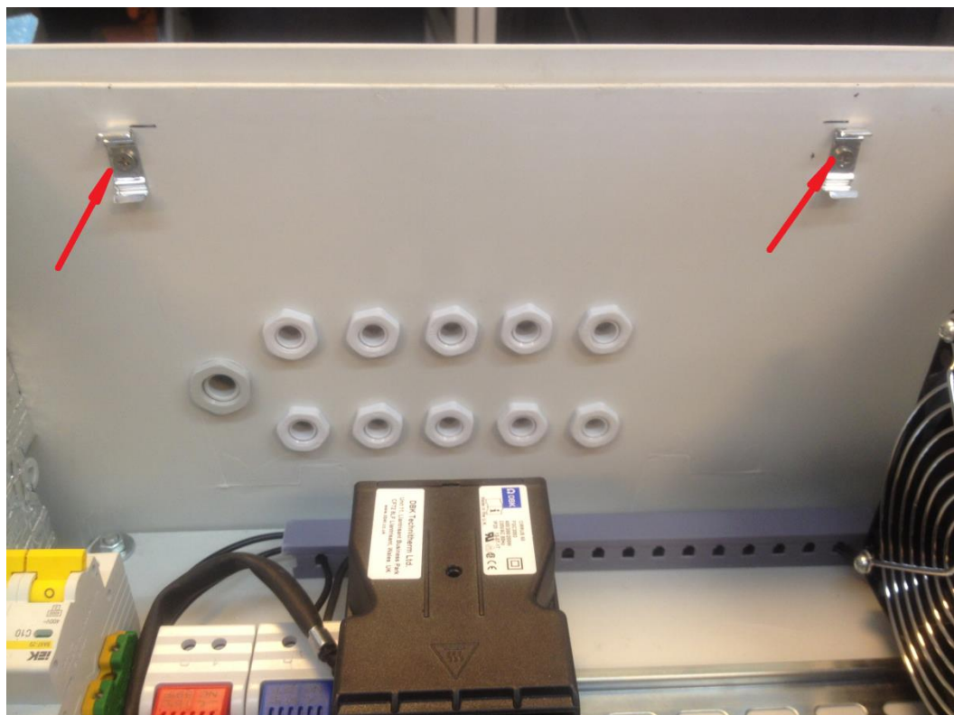
Рис.3.1.2-1 Установка пружинных креплений шкафа OSP.
