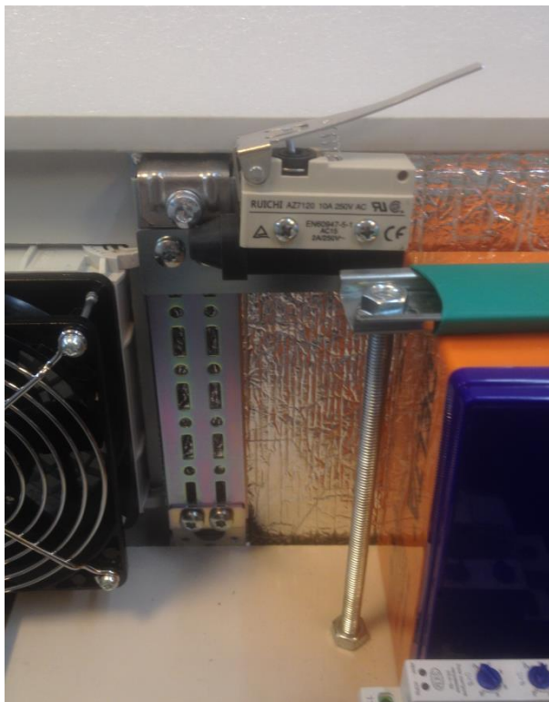
Рис.1-1 Установка датчика вскрытия в уличную станцию в пластиковом корпусе.
